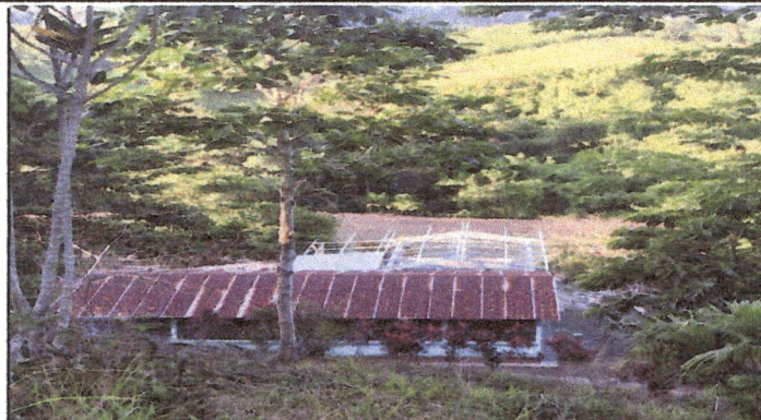
Foto 2: Colocacion de Lamina decorador y cosina
