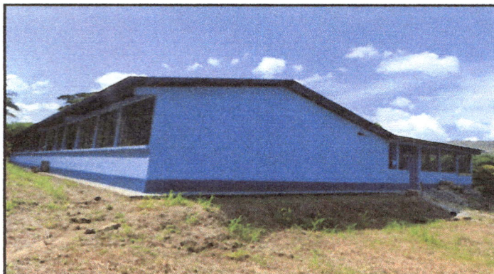
Foto 3: Trabajo de pintura al cien por cientos al lado del edificio
