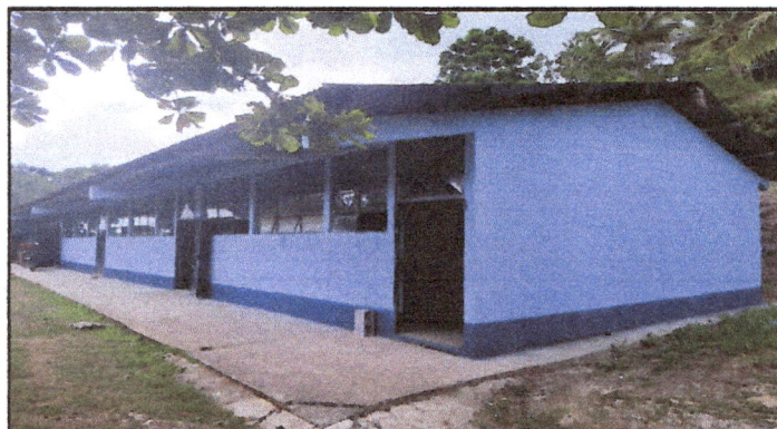
Foto 4: Trabajo de pintura en el lado de enfrente del Edificio escolar
